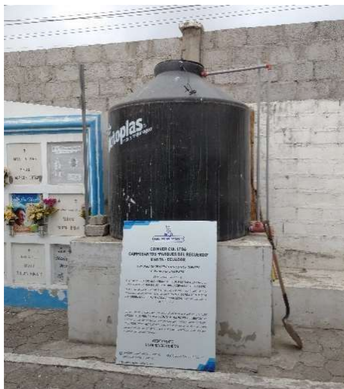
Fotografía 1. Tanque de almacenamiento de agua potable en el proyecto
